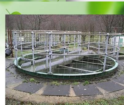
Отстойник первичной очистки
